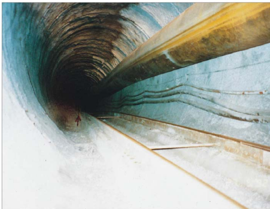
Σήραγγα εκτροπής Διάριζου υπό κατασκευή - Dhiarizos diversion tunnel under construction
