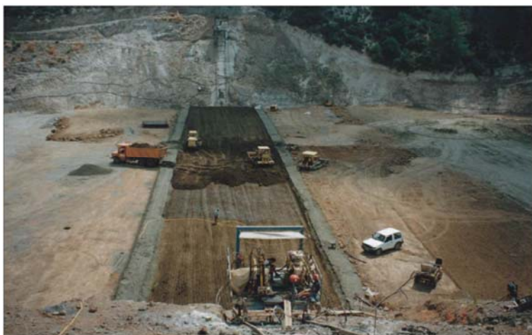
Κατασκευή αναχώματος - Embankment under construction
