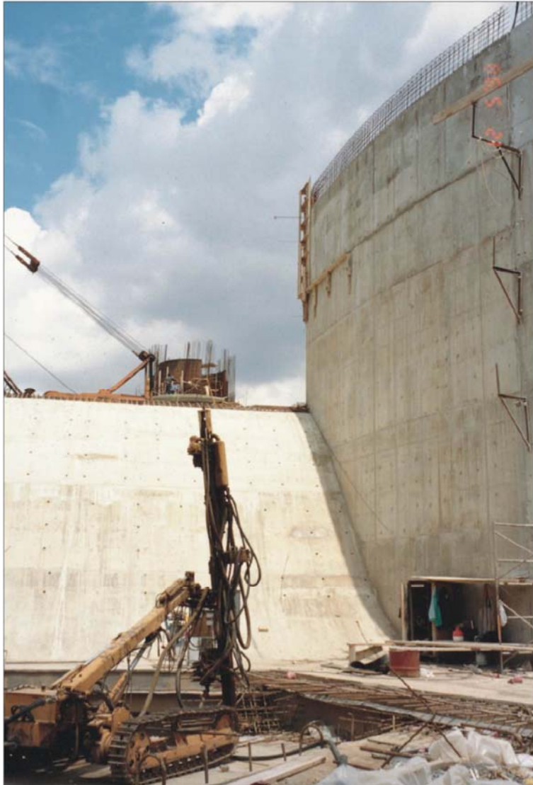
Υπερχειλιστής υπό κατασκευή - Spillway under construction
