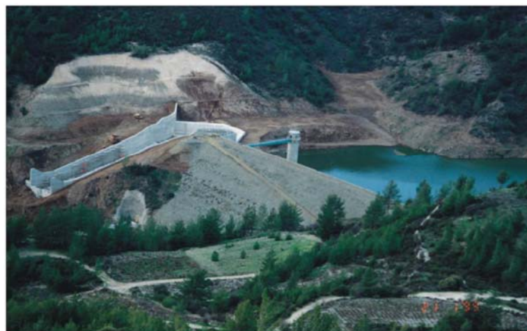
Γενική άποψη φράγματος - General view of dam
