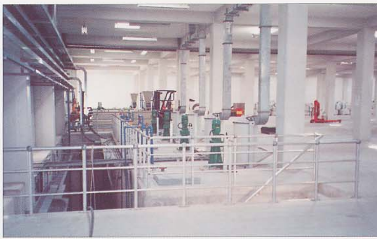
Δεξαμενές χημικών ουσιών - Alum & lime tanks
