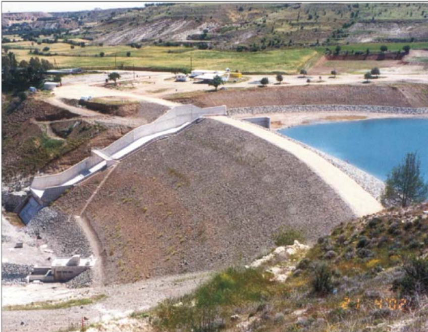
Γενική άποψη του φράγματος από το αριστερό αντέρεισμα - General view of dam from the left abutment
